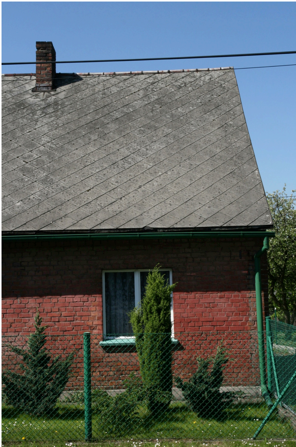
Rysunek 4 Dach budynku mieszkalnego pokryty płytami azbestowymi płaskimi Fotografia Agnieszka Chylak
